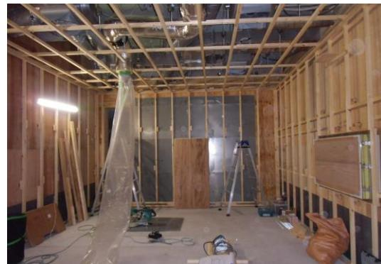
MRI室はこの後、新しい装置を迎えるために、壁・天井・床から磁場が漏れないようにするシールド工事や配管工事を行っています。室内の壁紙は落ち着いた色合いながらもスタイリッシュに生まれ変わります。8月下旬に新しいMRI装置がドイツから運搬され設置工事が始まります。新しいMRI装置の稼働開始予定は9月23日の予定です。
